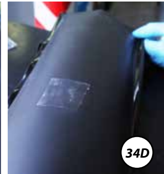
Abbildung 34 - Anbringen des Reparaturkits
